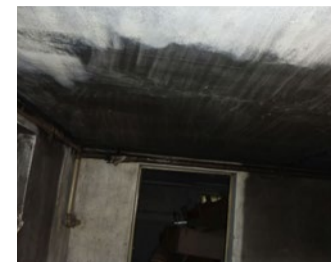
Gründliches Absaugen und Reinigen waren die Voraussetzung für die fachgerechte Sanierung der Räume (Bilder unten).
