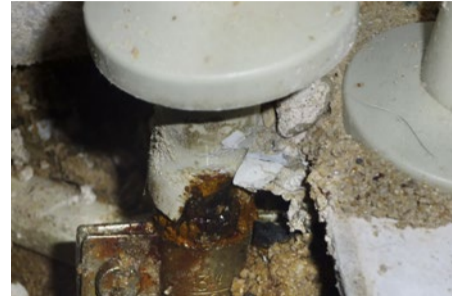
Ein kleines Loch im Heizungsrohr genügte in Crailsheim, um über einen langen, unbemerkten Zeitraum den Boden und von dort aus die Wände, Bodenleisten und Türfutter in der ganzen Wohnung zu durchfeuchten.
