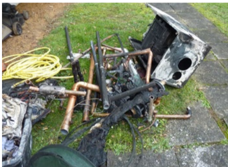
Die Heizanlage von der der Brand ausging, konnte nur noch demontiert und entsorgt werden.
