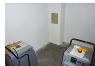
Leistungsstarke Trocknungsgeräte beseitigten parallel zu den Sanierungsarbeiten noch die Restfeuchte der Löscharbeiten.
